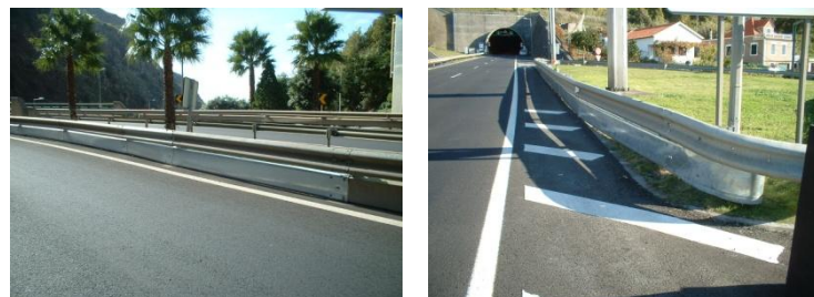
Reportagem da obra executada
